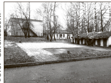
Площадка под МАФы на Пионерской, 9
