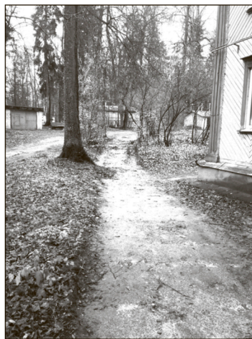
Ремонт дорожки у Победы 7, 9
